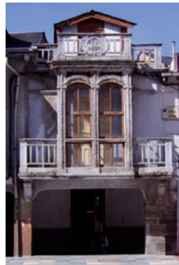
Casa de Riego (1928)
